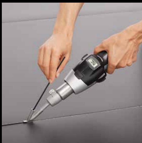
Сварка напольного линолеума
