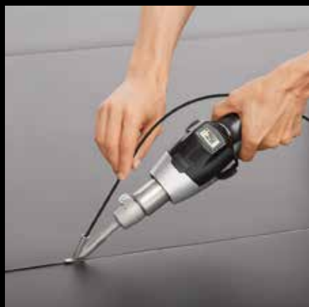
Сварка линолеума HG 2620 E
